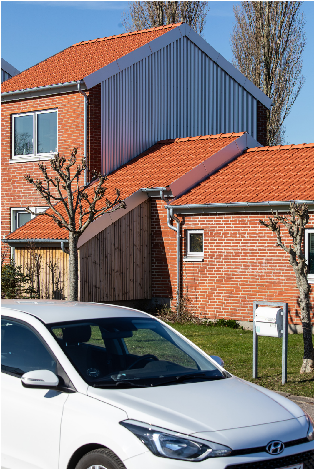
Renoveringen af Råhøjparken i Stavtrup: nye tage, nye badeværelser og indvendig ventilation til 221 rækkehuse.
