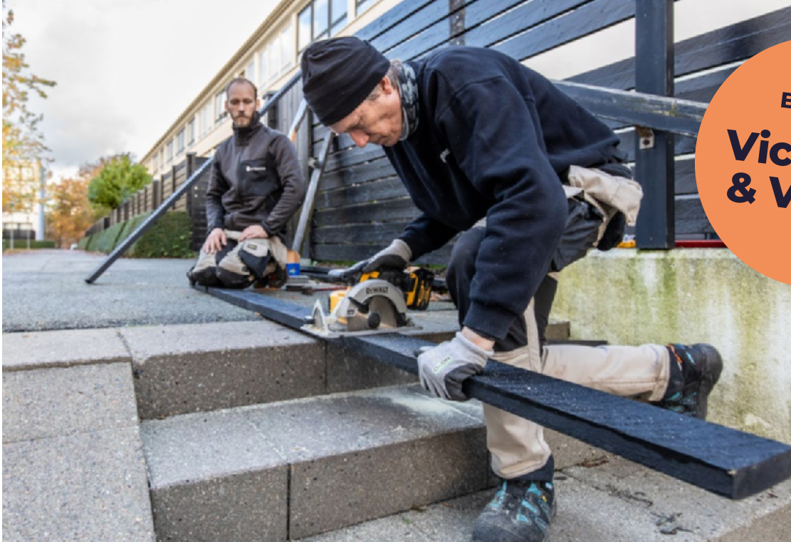
Renovering Vejlbj Vest
